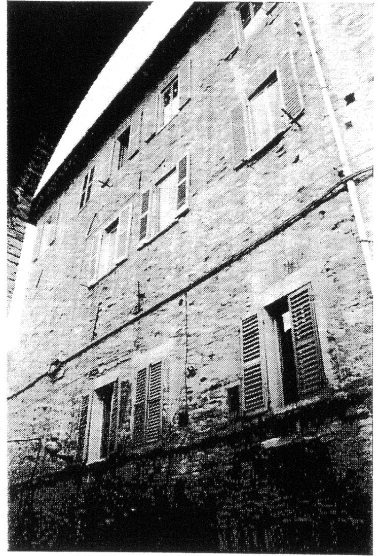
Infissi di alluminio anodizzato in una casa di Urbino fronteggiante le mura. Sono la spia di una incuria generale: oltre agli infissi, sono manomesse tutte le aperture di prospetto, rifinite a cemento e con dozzinali soglie lisce; i pluviali sono di plastica.
