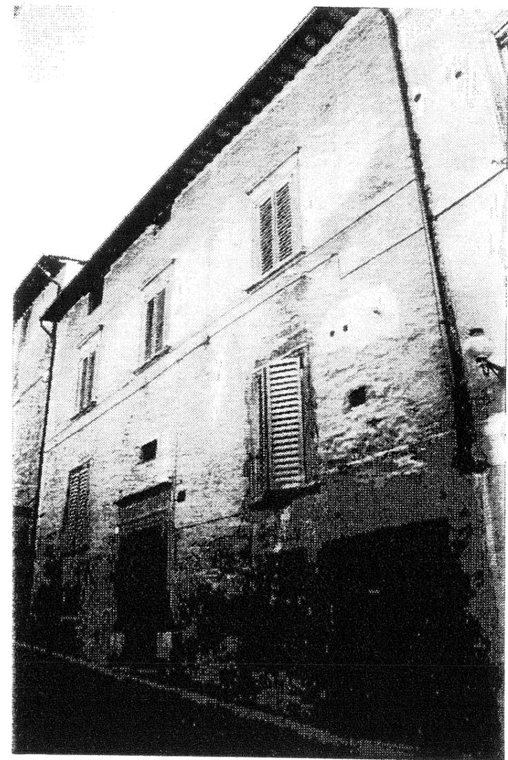
Esempi di muratura tinteggiata su intonachino a velo. L'intonaco forma una pellicola sottile che lascia trasparire la tessitura dei mattoni. E' qui evidente la mancanza di manutenzione che, per prospetti tinteggiati a calce, deve essere continua ed accurata.
