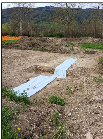
Figura 5 Geotessuto a protezione delle strutture murarie.
