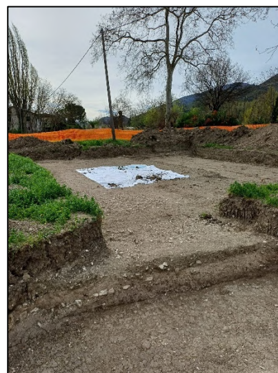
Figura 5 Geotessuto a protezione delle strutture murarie.
